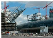
Abb. 17: Hauptbahnhof Berlin - Absenkung der beiden Hälften der westlichen Bügelbrücke beim Bau“ ..... 40
